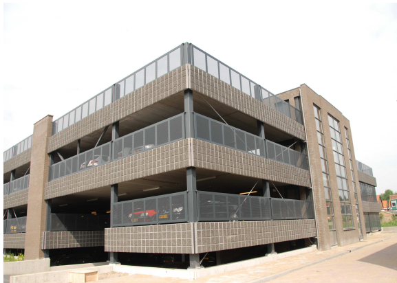
Parkeergarage Pesetastraat te Barendrecht
